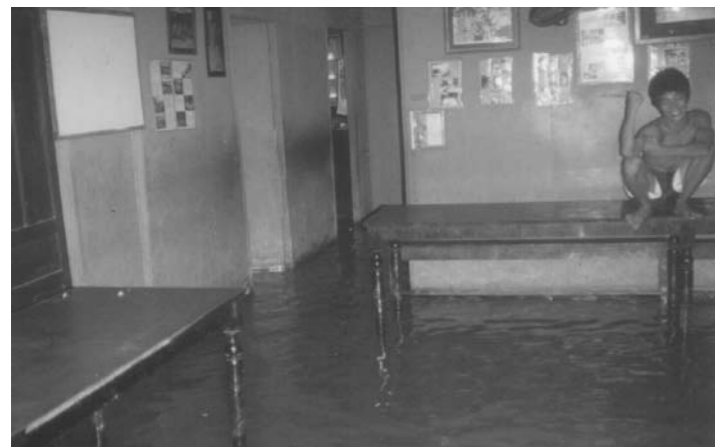
Août 2001. Vue de notre salle à manger inondée. Depuis plus de trois ans nous subissons les inondations et notre structure à été fortement détériorée. Pour résoudre le problème il faudrait rehausser notre terrain de 50 cm. Ces travaux auront normalement lieu à la fin de la saison des pluies, en octobre 2002.
