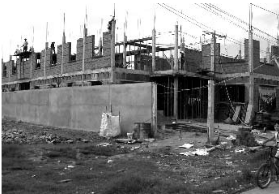
Centre Envol, début septembre, le chantier
